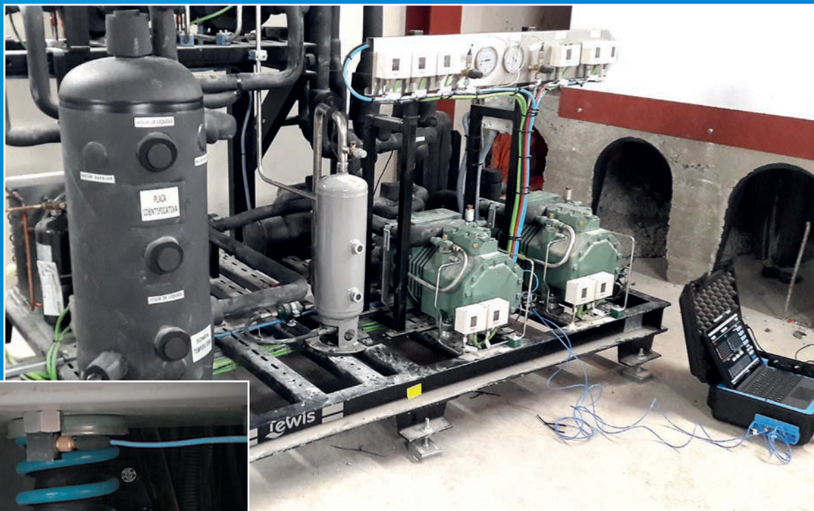
Medición de vibraciones
